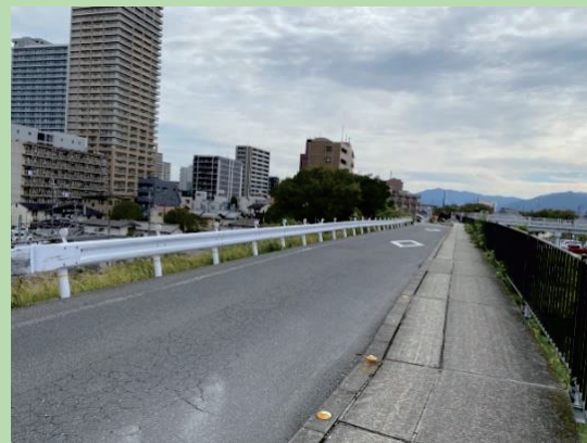
▲旧草津川JRトンネル上道路
